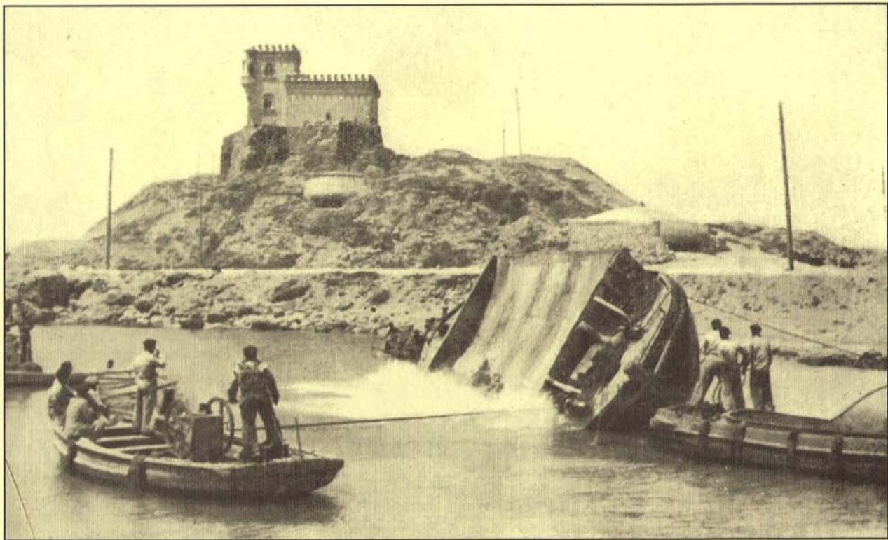
Vertido de escollera en el trasdós del muelle número 3 de Tarifa durante su construcción . Fotografía tomada del libro «Terminación del puerto de Tarifa» de Antonio Durán y Manuel Álvarez.
