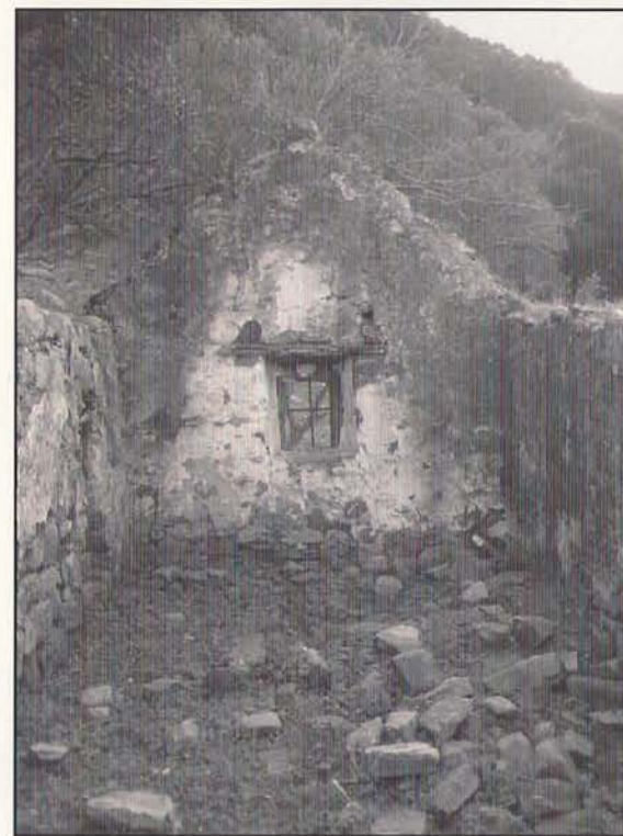
Las casas suelen tener pequeñas ventanas con dintel de madera y rudimentaria reja.
