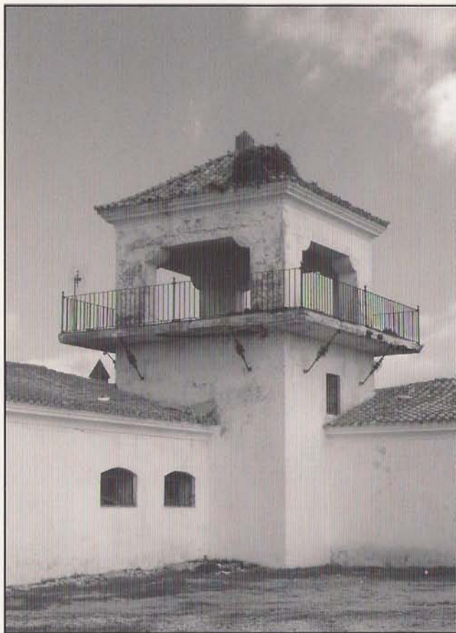
Otra de las torres mirador del cortijo de Tapatana.
