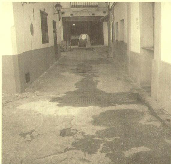
*Pavimento mal asfaltado y con socavones en
